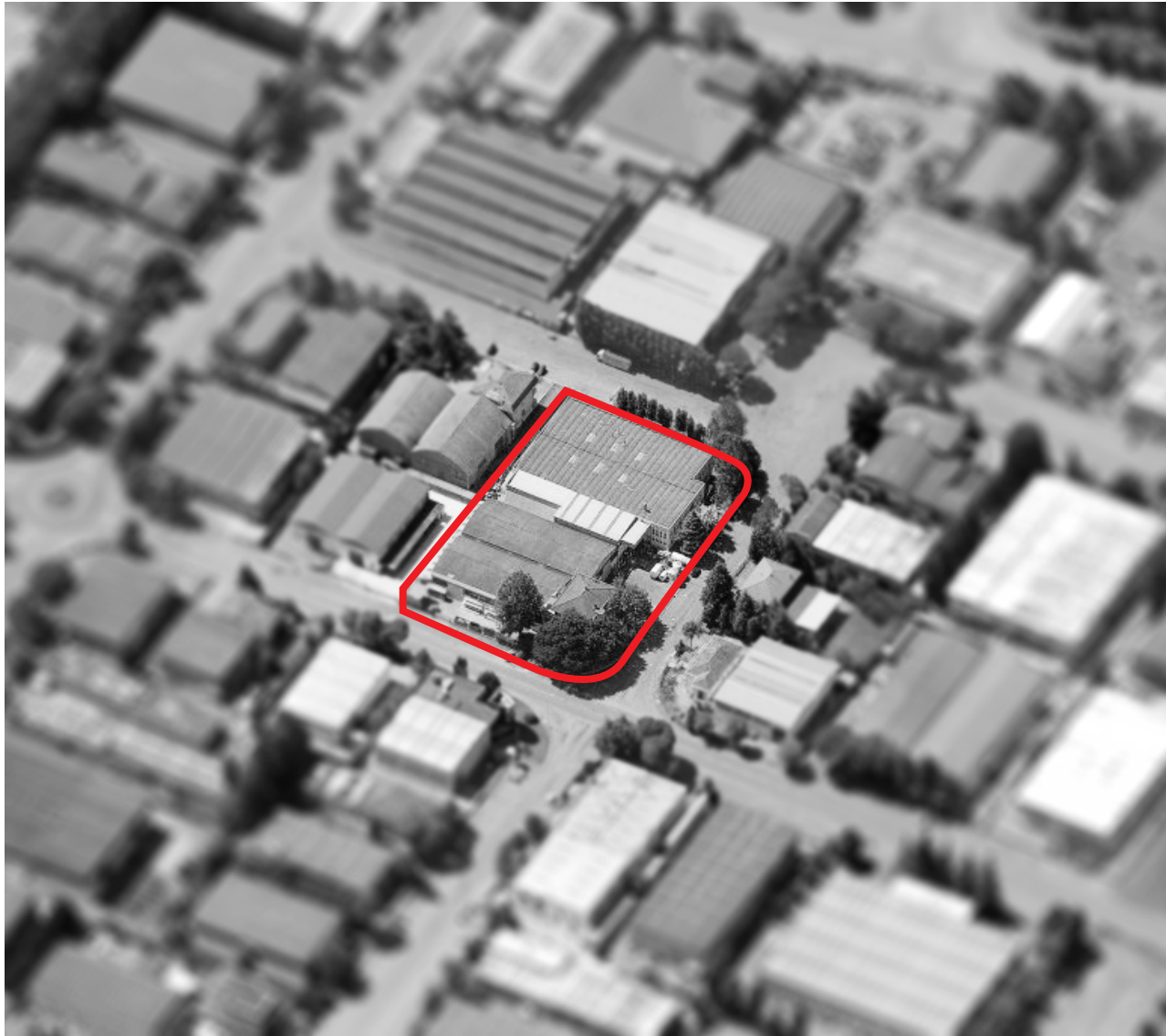
Sede central y planta de producción principal - Forlì (FC) Italia Sede central e establecimiento productivo principal - Forlì (FC) Italia
